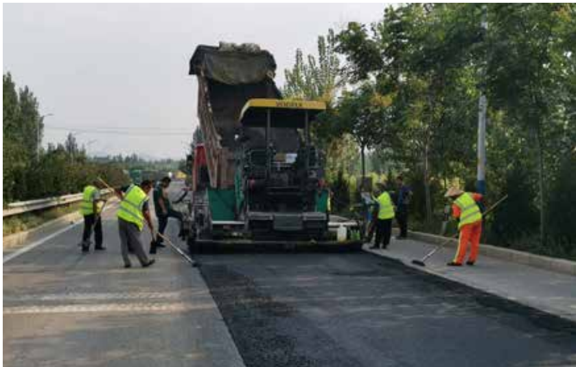
国道路面摊铺
