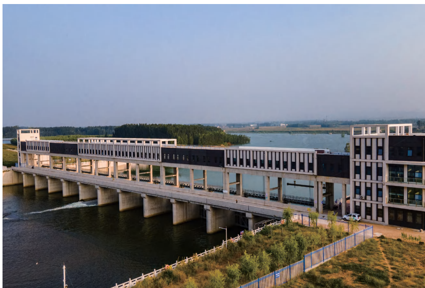
9 月，泗河岳陵拦河闸（中型）竣工验收
