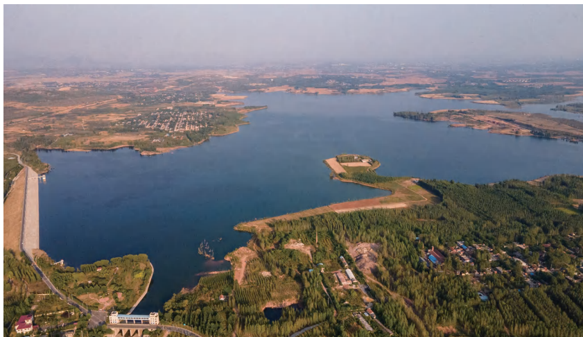
5 月，龙湾套水库被列入现代化水库运行管理矩阵建设国家级试点水库 (冀延刚 摄)
