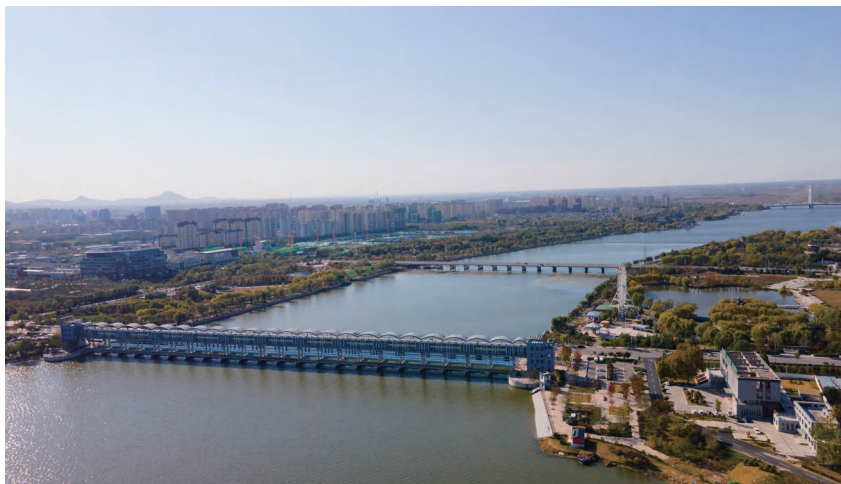
2 月，泗河泗水大坝被水利部评为全国标准化管理工程 (冀延刚 摄)
